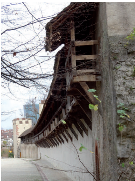
Fig. 15: Wehrgang der Letzimauer. Parapet walk of the Letzimauer. Chemin de ronde de la Letzimauer. © Christian Luczak.
